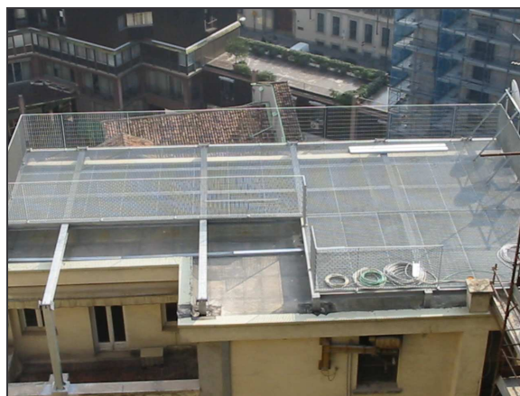
TETTO QUOTA + 36,00 PRIMA E DOPO IL POSIZIONAMENTO DEI MODULI TERMICI
