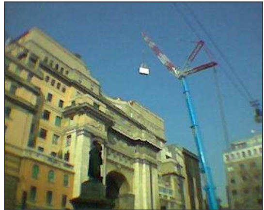
FASE DI SOLLEVAMENTO SUL TETTO QUOTA + 56,00
