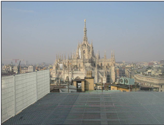
TETTO QUOTA + 56,00 PRIMA DEL POSIZIONAMENTO DELLE MACCHINE
